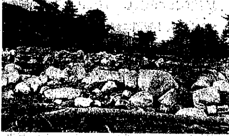
図-17. 住吉川上流阪急電鉄附近 線路埋没状況
