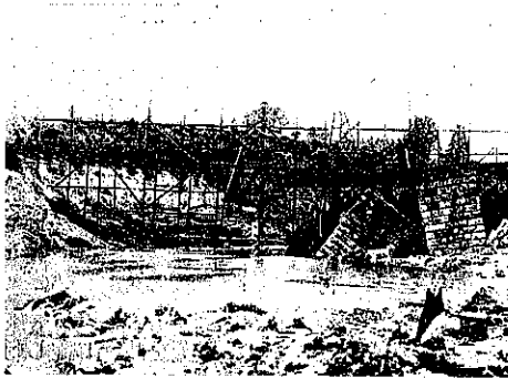
図-6. 常磐線岩間・友部間下河原橋梁橋臺倒潰 (95 km 414 m 附近)
