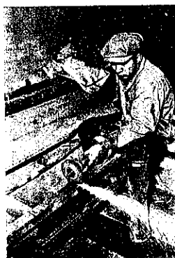
軌條頭部熔接個所の略仕上げ
