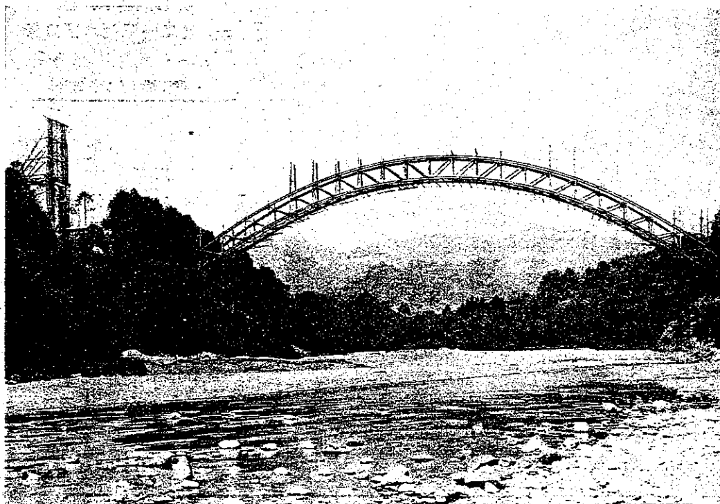
弊社製作架設 = 係ル東京府與多摩橋
