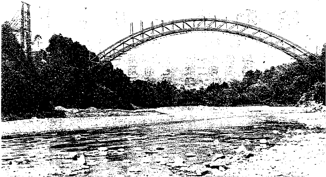
弊社製作架設 = 係ル東京府與多摩橋
