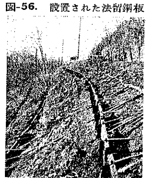
図-56. 設置された法留鋼板
