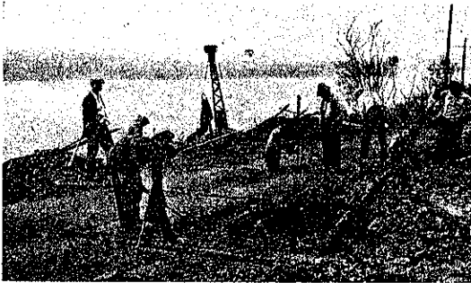
図-54. 現存道路を横切つてアンカーバーの敷設
