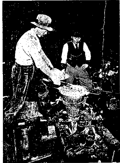
圖-7. テルミット配合劑の一點に熱を加へる(點火劑に炭火にて點火する)
