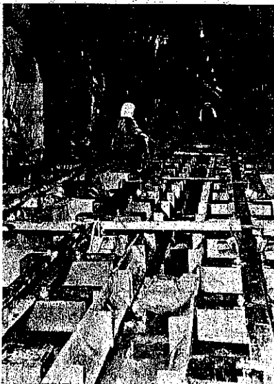
図-26. コンクリート打込直前
