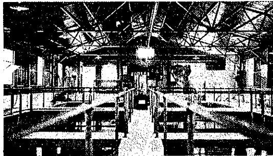
図-58. 汚泥搬出用軌道の設備を有する汚泥乾燥床
