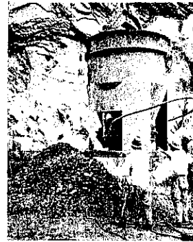
パイプレーターによる搗固め
