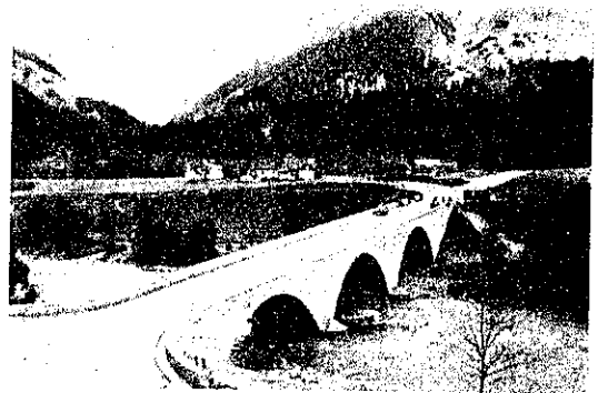
図-37. 完成せる橋梁全景
