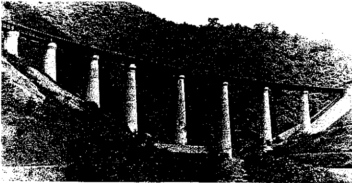
完成せる第一小鳥原川橋梁
