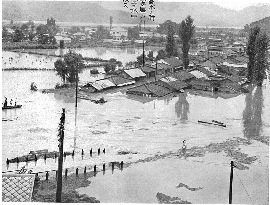
(1) 無堤防地域の洪水氾濫状況
