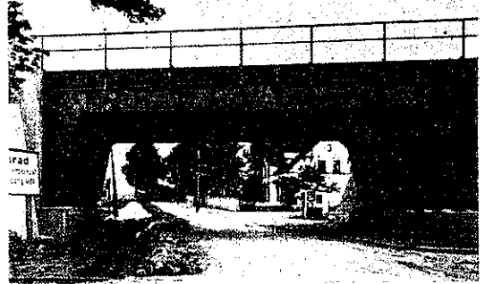
図-6. 図-5 の溶接ラーメンの運搬
