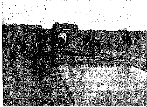
第 11 圖 コンクリート鋪装作業
