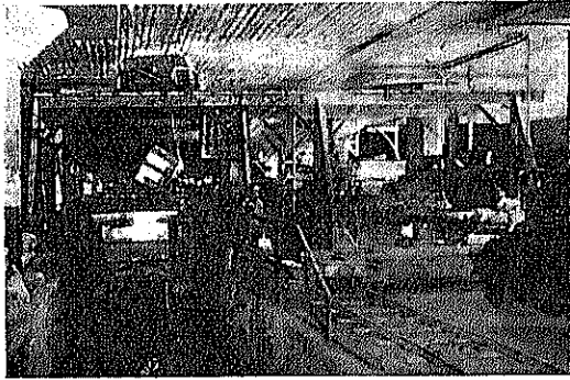
第 130 圖 Wacker Drive 堅坑に於ける門形起重機
