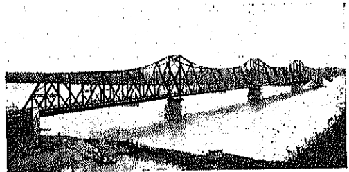
第 49 圖 匈牙利 Dunaföldvár 橋梁全景
