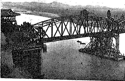
第 27 圖 第 1 號トラス架設 (7) 引出し終りて船船に水を入れて据付け解船移轉して 他端をも据付けて架設を終る
