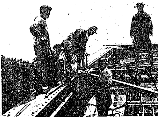
第 22 圖 第 1 號トラス組立 (2) 鉸鎖作業 (インガーツール製コンプレッサー 15 馬力使用)
