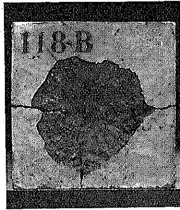
第 15. 裏面の破壊状況
