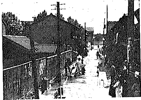
第 7 圖 昭和 10 年 6 月 14 日 淺草區藏前町 1,2 斷水中應急給水裝置を施し使用中
