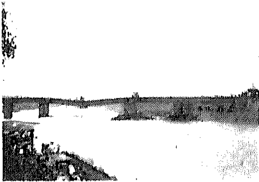
第3圖 奈良線和歌山 京都間輪川橋梁 其の1 第7號橋脚の倒壊せる狀況(20日午前9時發生)
