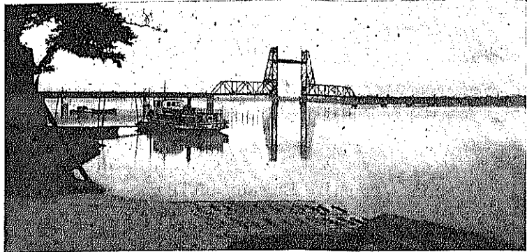
第 2 圖 筑後川橋梁全景(昇開式) 矢部川方上流より望む
