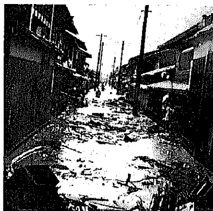
(4) 七條大橋西詰下ノ宮町浸水状況
