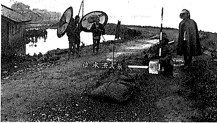
(18) 筑後川堤防缺口所應急工事 (三養基郡南茂安村天建寺)
