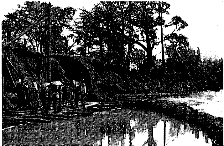
(16) 大阪府芥川右岸堤防崩壊箇所緊急工事状況（高槻町那家地先）
