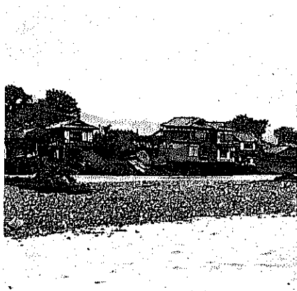
(3) 鴨川御園橋附近左岸道路及洪水敷決壊 (家屋の前面約4mの道路流失)
