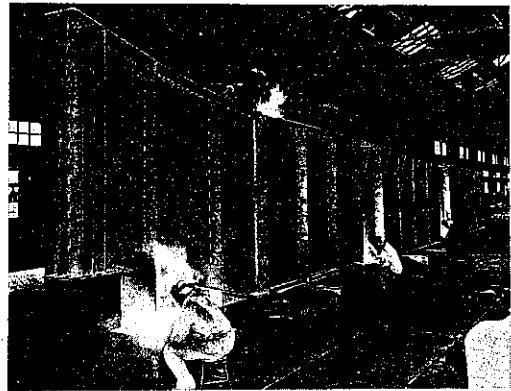
寫眞第 3 工場に於ける主桁溶接作業
