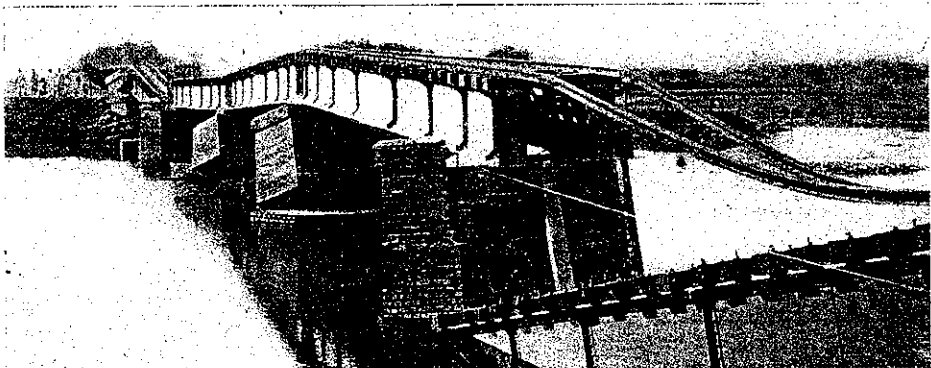
第 27 圖 Lakandai 橋梁、橋脚は剪斷されて線路方向に押された。従つて ガーダーは一部其の儘河中に墜落又は橋臺上に押し上げられた
