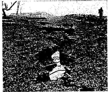
第 26 圖 地表面の龜裂
