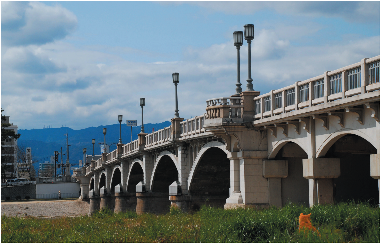
5 武庫大橋左岸橋詰より
