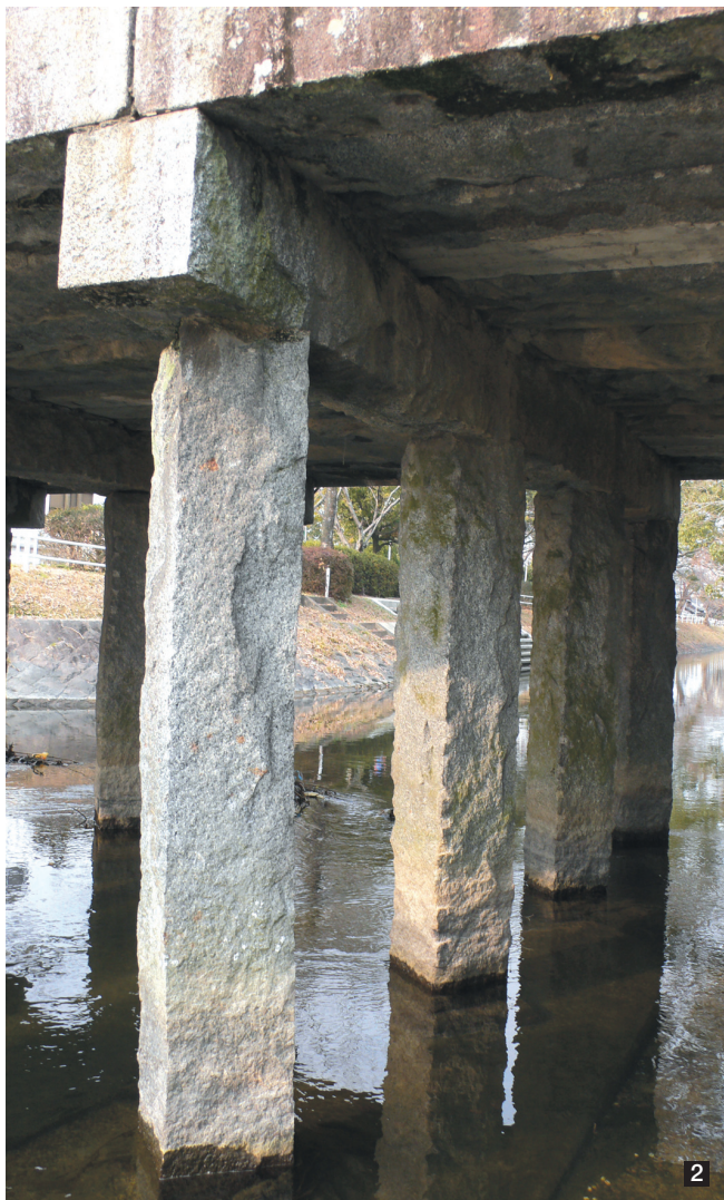
1 梅檀橋の繊細さと多布施川の 木々の豊かさ 2 梅檀橋。橋脚のディ テール 3 石井樋。当時の仕組みを 今に伝える 4 神野公園。大池を挟 んで向かって左にお茶屋、右に隔 林亭(茶室) 5 梅檀橋の位置図
