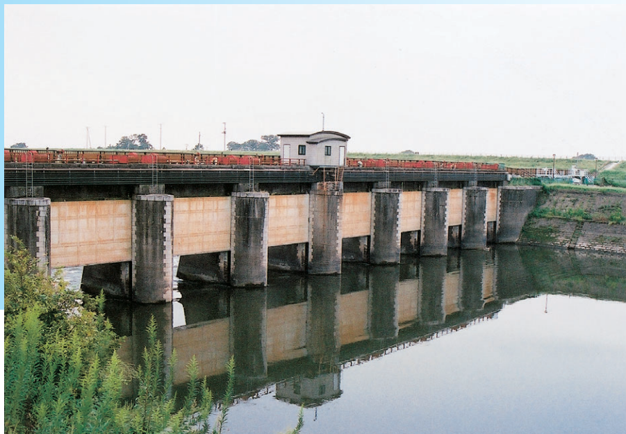
写真-1 上流側よりの水閘門(全て撮影：著者)
