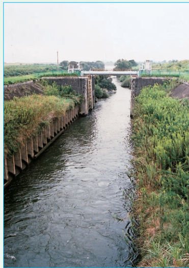
写真-2 閘門内部の様子(手前が上流側)
