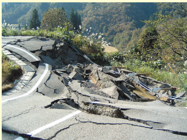
写真-5 山古志村内の道路盛土の崩壊と大量の湧水
