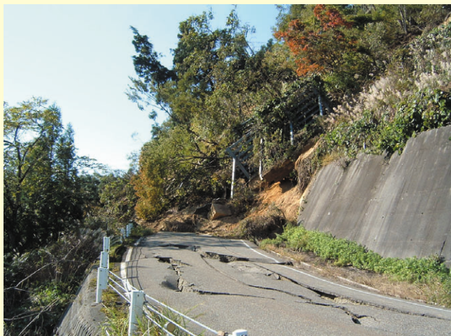
写真-14 山古志村へと繋がる道路を分断する法面崩壊
