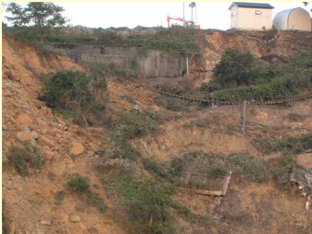
写真-9 盛土部の崩壊により線路が宙吊りとなっている信越線と、不通が続く国道17号
