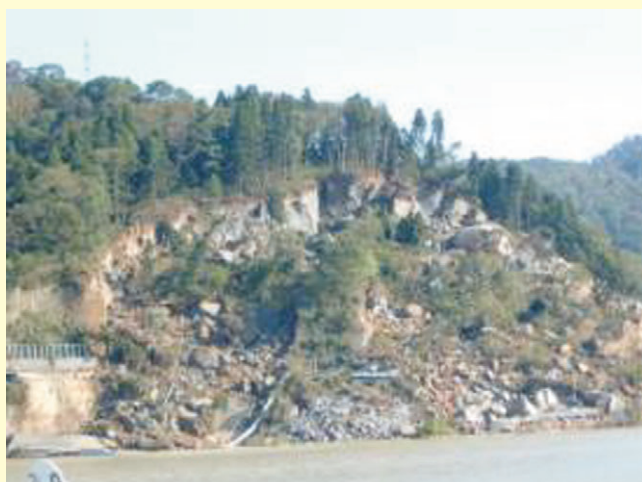
写真-7 白岩での尾根の道路切土法面の岩石崩壊現場。埋まった女の子の救出が続いていた
