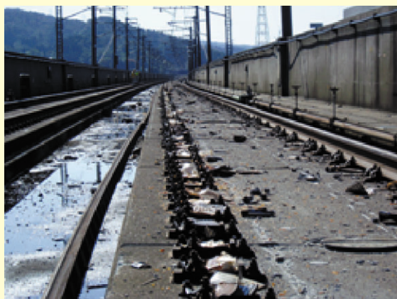
写真-7 脱線付近の軌道の状態
