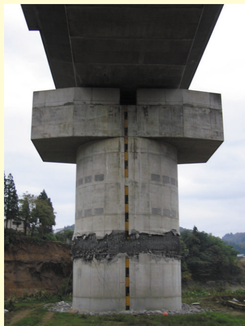
写真-11 魚沼川橋梁（RC橋脚の段落し部における損傷）（写真提供：睦好宏史）
