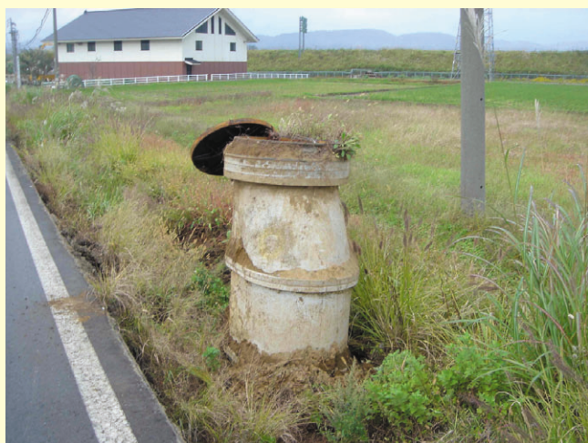
写真-8 マンホールの浮上り（小千谷市吉谷地区） （写真提供：安田 進）
