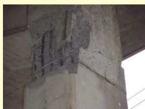
写真-9 村松高架橋（コンクリートの剥落） （写真提供：睦好宏史）
