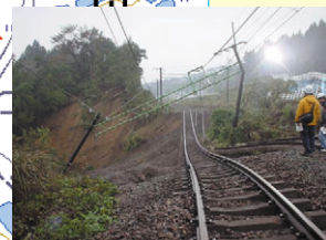
写真-1 図-6中(A)地点での斜面崩壊：川口町天納付近（写真提供：小長井一男）
