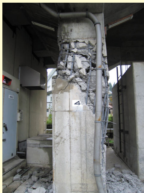
写真-10 第一和南津高架橋（RC柱のせん断破壊） （写真提供：睦好宏史）
