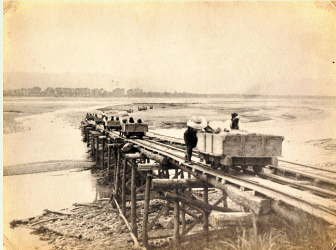
写真-3 トロッコを使った工事風景(提供:三井住友建設㈱ 静岡支店)
