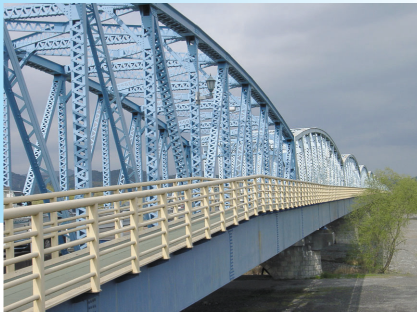
写真-1 大井川橋の現況(筆者撮影)
