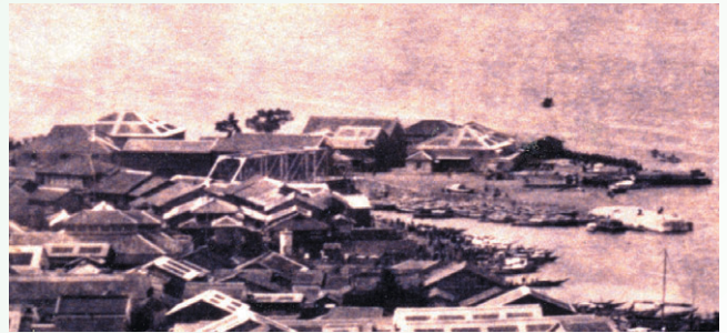
写真-4 1892(明治25)年頃の「新川口橋」
