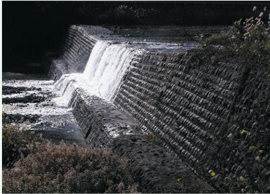
写真-3 現在の源堰堤(高さ:8.8m,長さ:107.3m)
