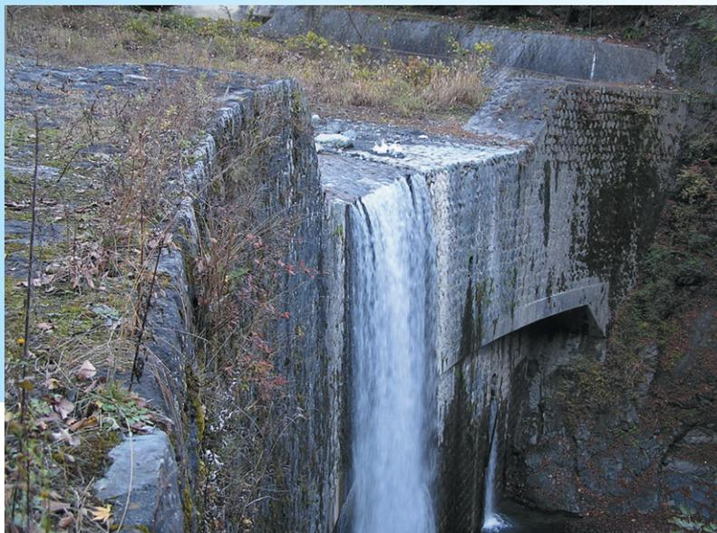
写真-1 現在の芦安堰堤(高さ:22.65 m,長さ:66.6 m(アーチ部))
