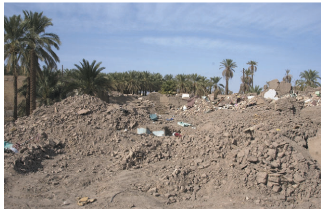
写真-7 アドベ住宅の倒壊状況
