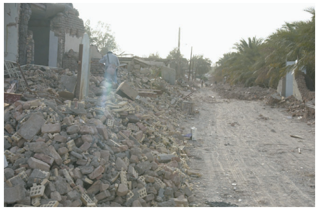
写真-6 無補強レンガ造の被害状況
