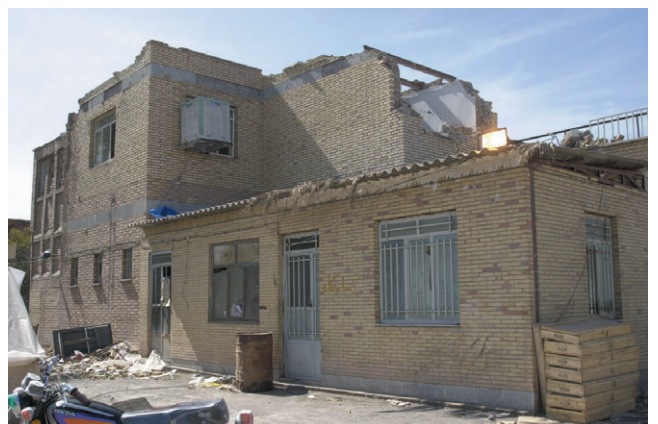
写真-3 強震観測点の建物
