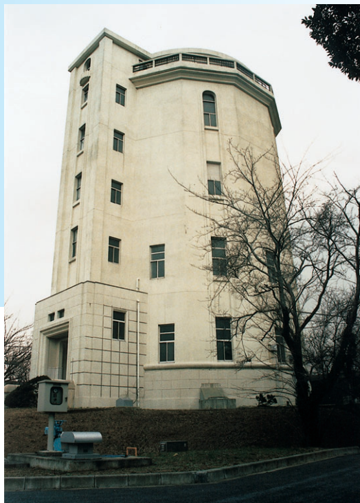
千葉高架水槽の塔：現状
