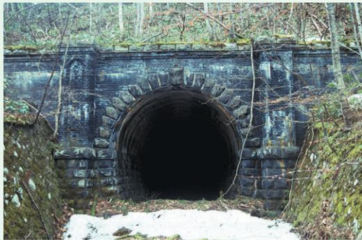
写真-2 新内隧道・煉瓦造であるが側壁には付近で産出する石積を用いている。線路の側溝にも同じ石材が使われている。
