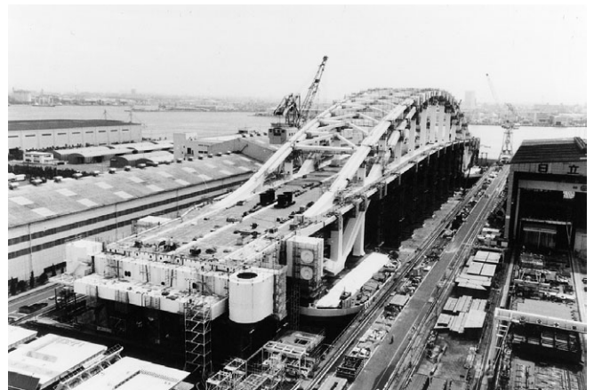
写真-2 ドック内架設状況
