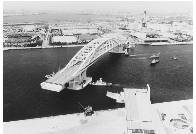
写真-5 現地据付
