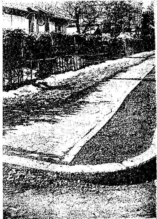
第 12 圖 歩道煉瓦舗装の被害状況
