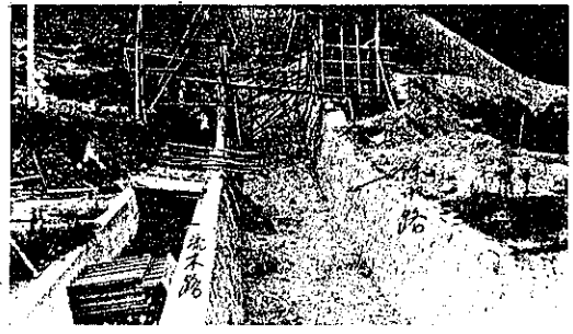
第 7 圖 餘水路及び流木路
