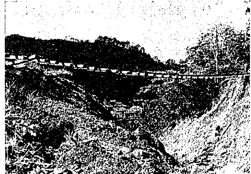
第 10 圖 山陰線莊原・直江間水行川附近築堤流失
