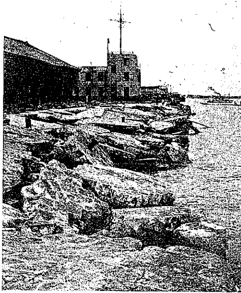
大阪築港南第4号上屋と其の前面護岸の破壊状況
