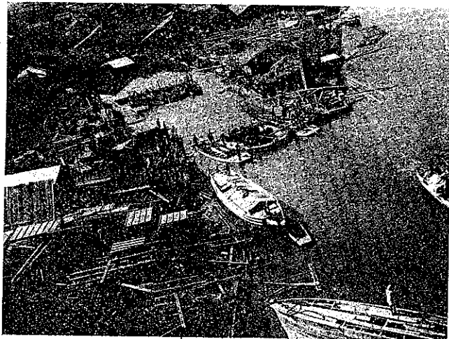
寫眞第3 満潮時ドックより井筒引出し
