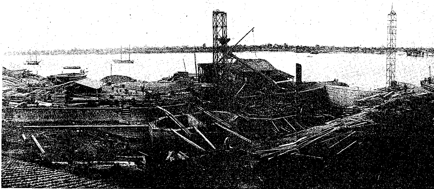
寫眞第2 ドック内井筒(第1ロット)築造
