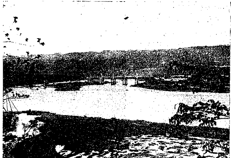
第 1 圖 取水堰堤工事中流量 50000 個の出水
