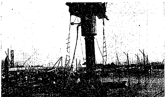
第 6 圖 作業室内の水を排除しつつある所
