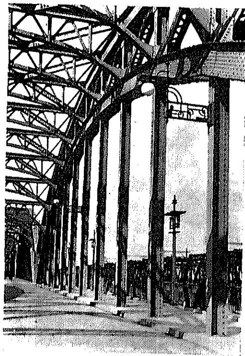
寫真第五 鋼桿橋可動滑
