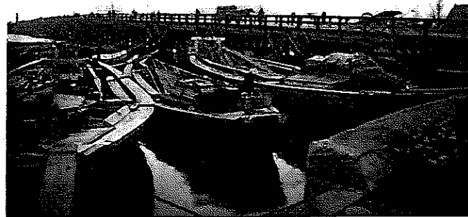
寫眞第二 沈面沈下工事
