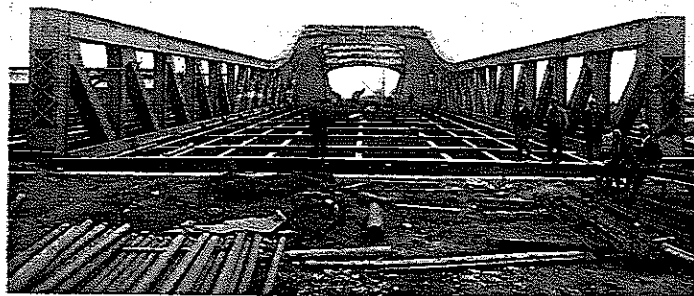
寫眞第十八 床版コンクリート打
