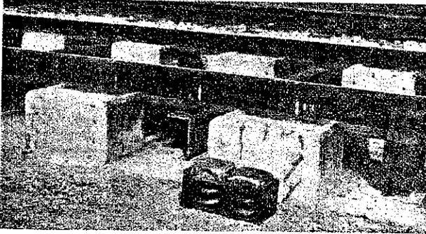
新考案に依る軌道の構造を示す、前に取り出したのはパネである、其の後に植込ホルルトが突出して居る
