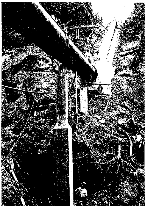
寫眞第二十二 溪谷横斷の支柱
