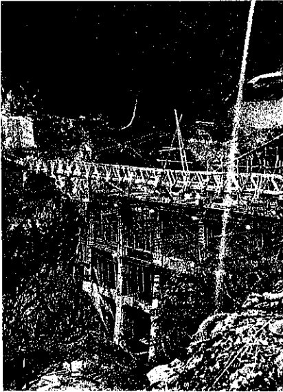
寫眞第七 堰堤頂部工事
