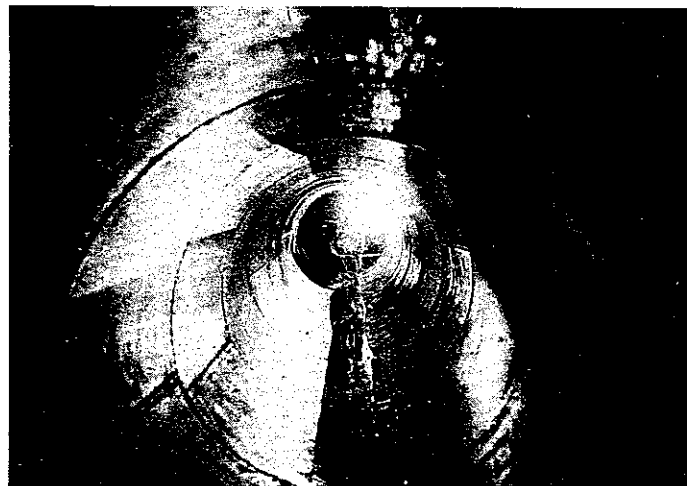
寫真第四 鐵管掘付工事完成
