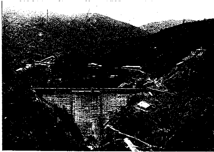
寫眞第十四 完成せる堰堤（下流側）
