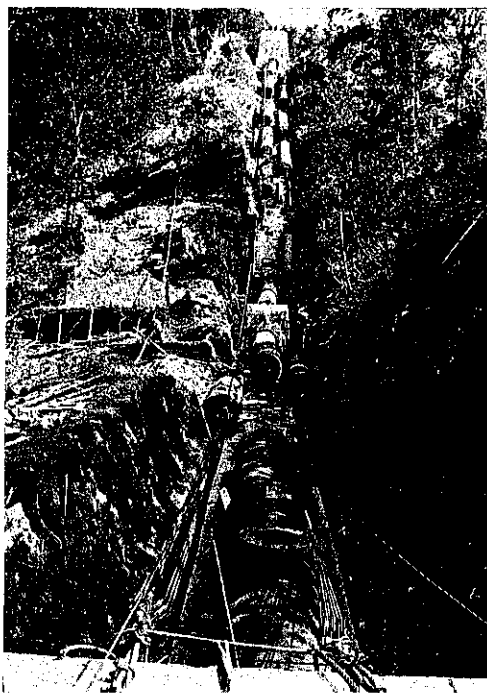
寫眞第二十二 溪谷横斷の支柱
