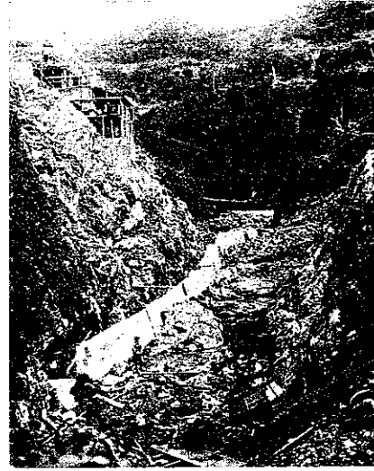
寫眞第十 小口川第三發電所工事祐延堰堤基礎掘鑿
