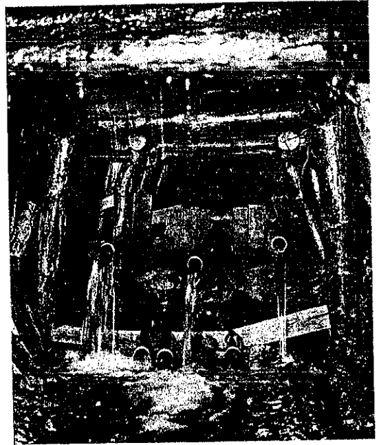
上部 3 個の鐵管は試錐孔よりの湧水，下部鐵管は切端附近湧水の排水管
