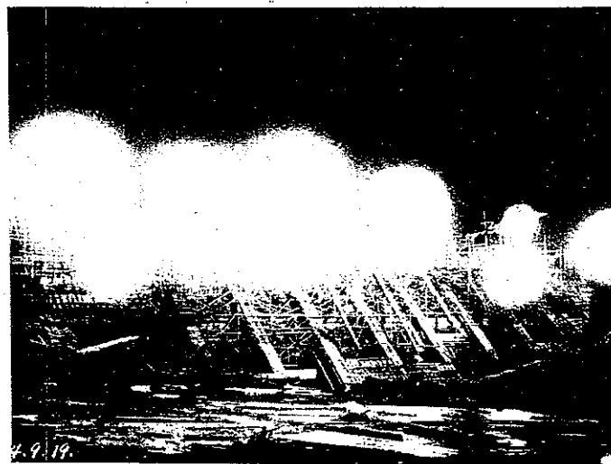
寫眞第四 調整池堰堤前面より見たる夜業の光景
