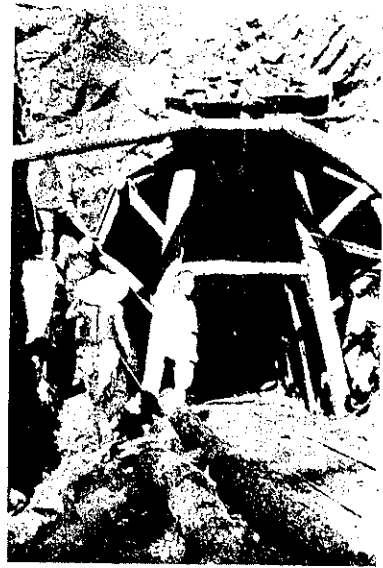
寫真第六 隧道支保工
