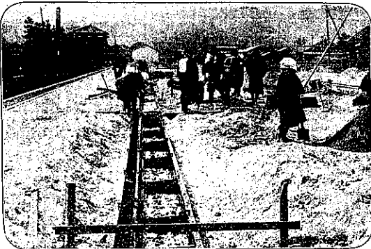
路面附屬工、全部 コンバインドガッターにして床拵への上 1 間置きにナビジョンプレートをも有せる鐵型を組立て、 場所詰混凝土にて施工す、工程甚だ迅速なり
